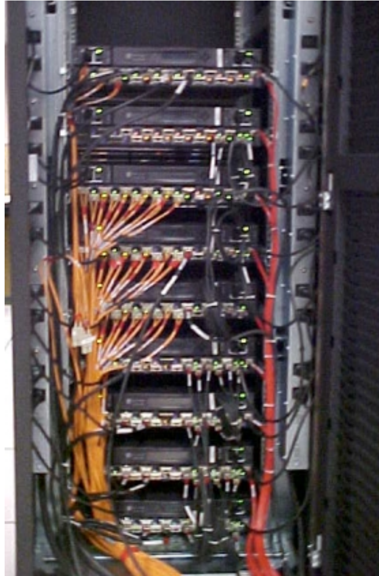
Fabric B Wiring
